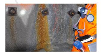
Die Wahl des Rohres ermöglicht es die Belastung des Ankerbolzens zu bestimmen. Zum Bsp. Für einen 46UAnker gibt es 4 verschiedene R32 Röhre, von **210 bis 360 k**N.
